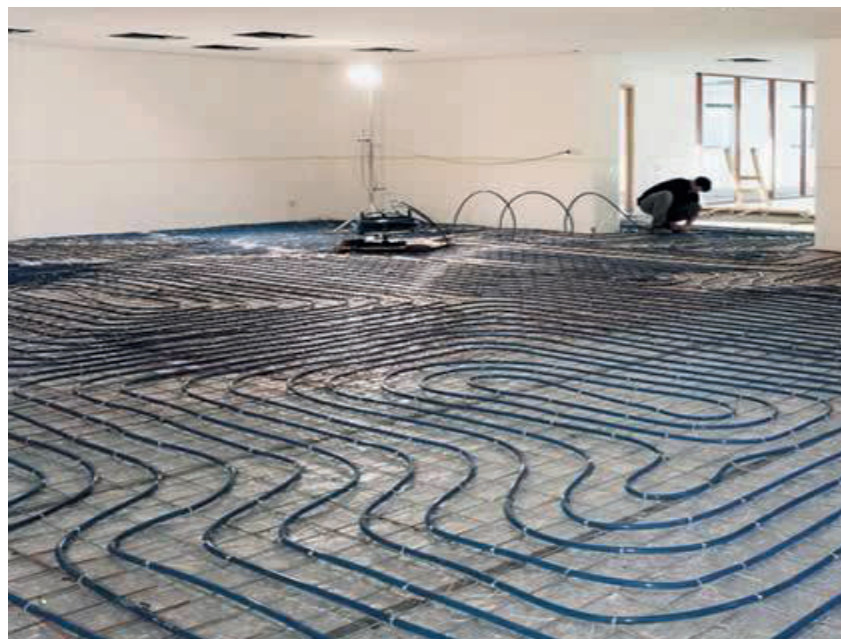
AANLEG VLOERVERWARMING [WWW.E-VILLAS.BE]
